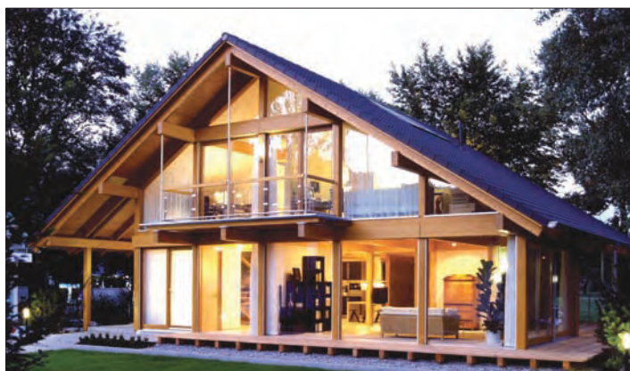
Veľké presklené plochy vďaka svojim vlastnostiam nezvyšujú náklady na vykurovanie!
